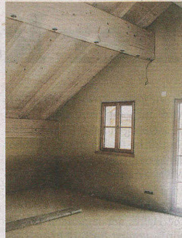
Zu sehen ist eine Aufnahme, die während der Rohbauphase entstanden ist.
